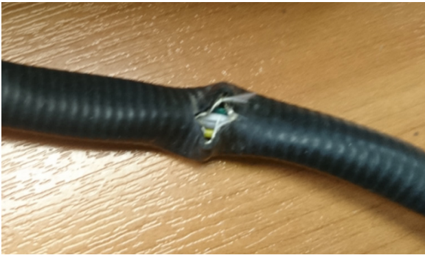
Figura 13. Figura 13. Protector de cable dañado.
